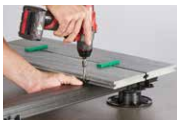
5. Weitere Klammern montieren
