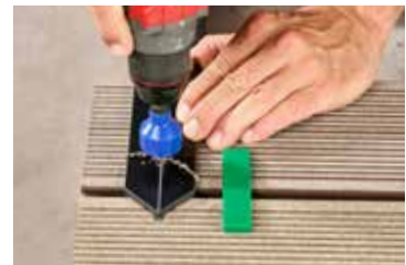
2. Bohrlöcher mit Bohrer markieren
