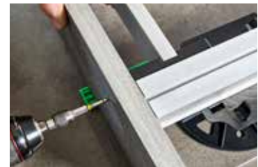
1: Blendenbefestigung mit Profilverstärker siehe S. 28–29
