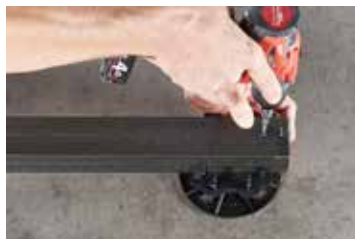
1. Anfangs- Endklammer montieren
