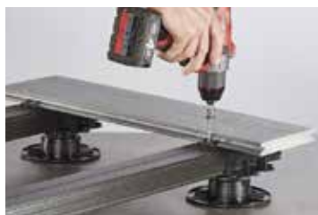
3. Montageklammern montieren
