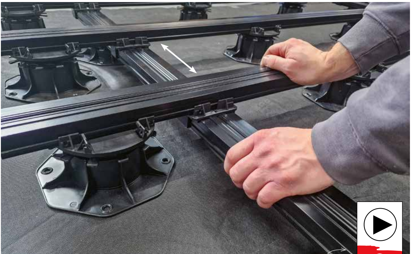
Fixierte Alu-UK einfach an die exakte Position schieben
