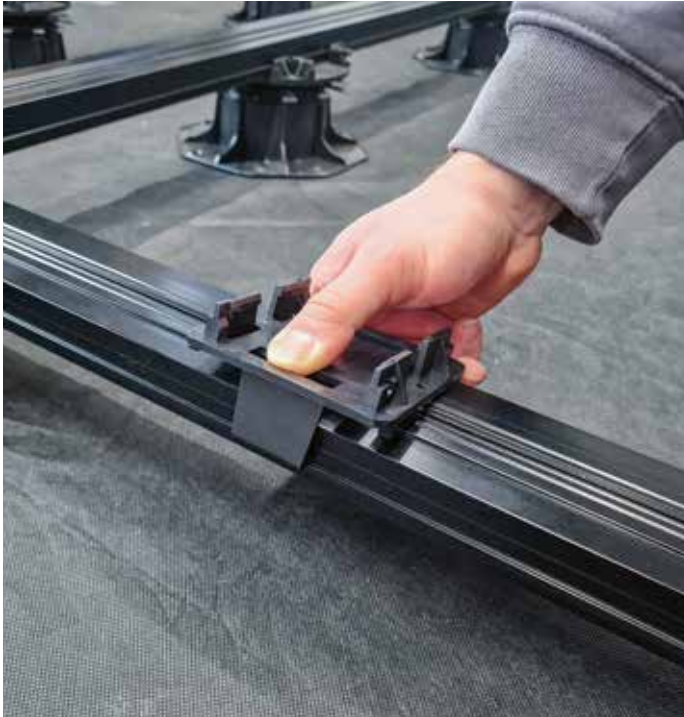
KL-Kreuzverbinder auf die ausgerichtete Konterlattung einklicken
