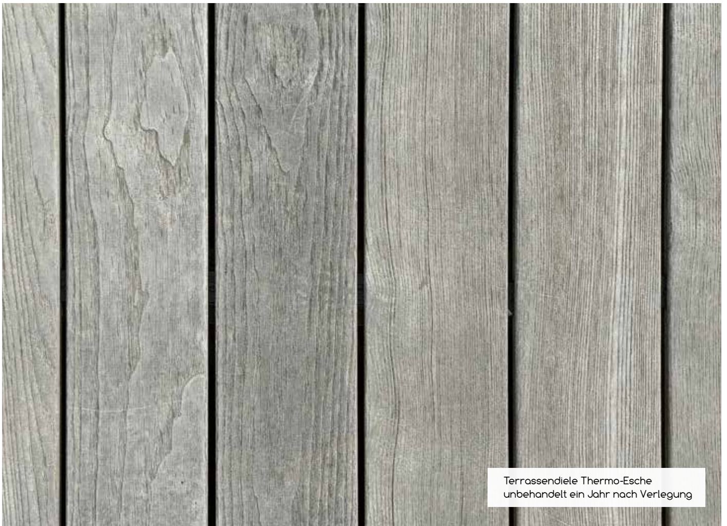
Terrassendiele Thermo-Esche direkt nach der Verlegung
