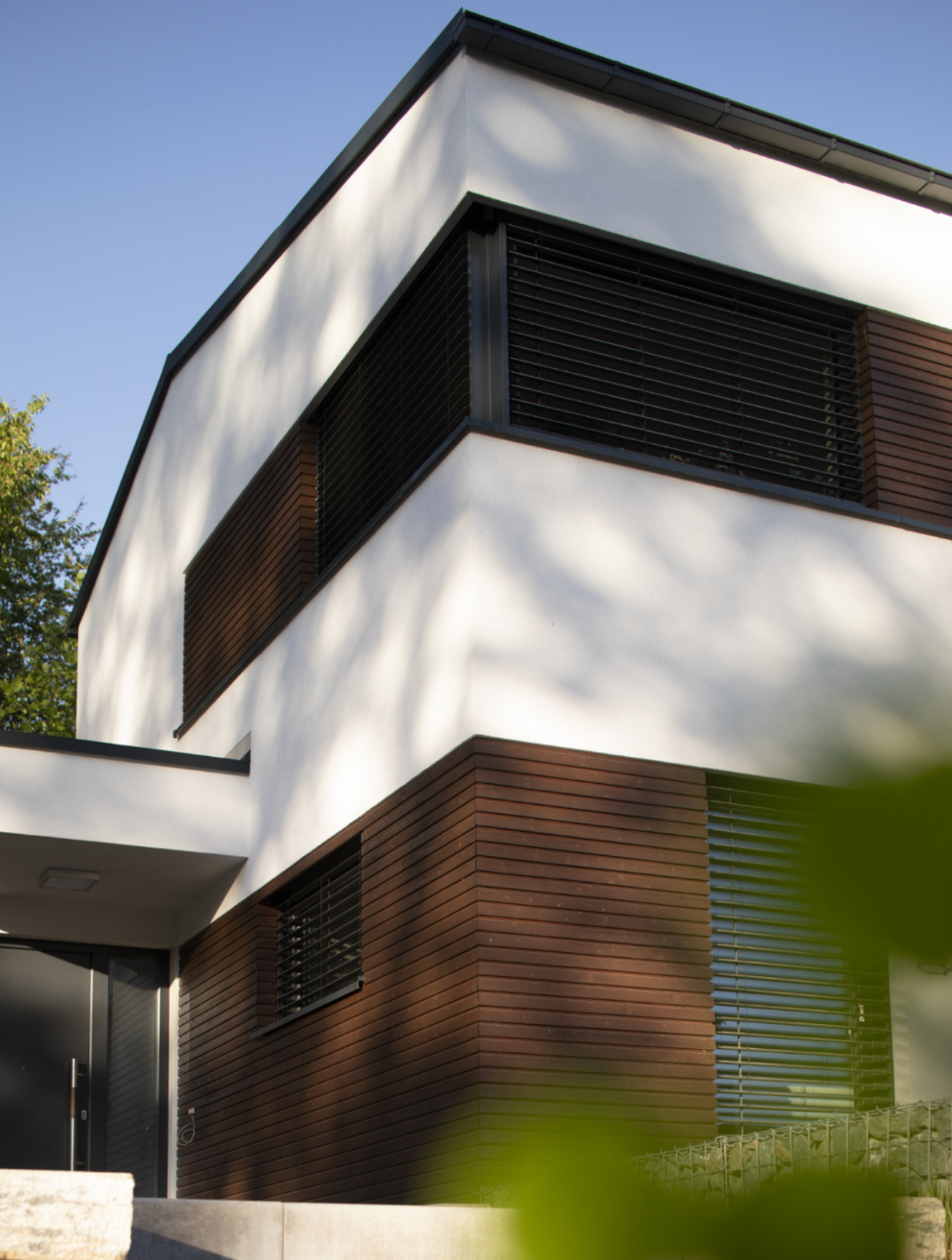
Rautenprofil mit Nut und Feder, nordische Fichte, endbehandelt mit Osmo Holzschutz Öl-Lasur 727 Palisander
