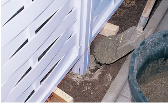
Zaunpfosten direkt ins Erdreich einbetonieren...
