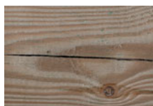
Spannungsrisse durch die Holz Trocknung
